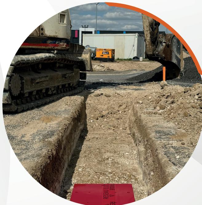
Grâce à leurs performance et à leurs simplicité d'utilisation, nos plaques « RESOPROTEC PREMIUM » en PEHD représentent une solution de premier choix pour la protection mécanique des réseaux HTA et BT.
